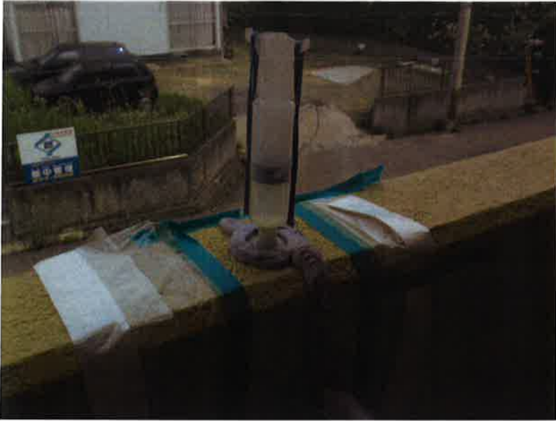
ひび割れ補修工事
